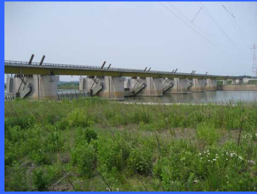
③ 右岸仮締切りより
