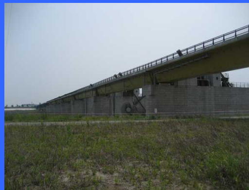
① 左岸仮締切りより
