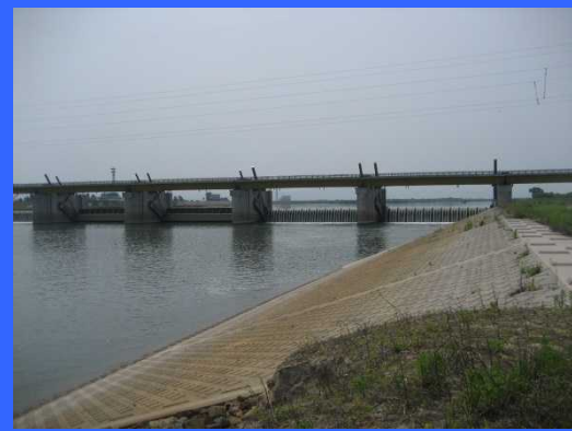
④ 左岸魚道下流より
