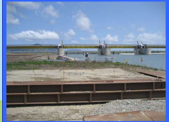
② 左岸魚道上流より
