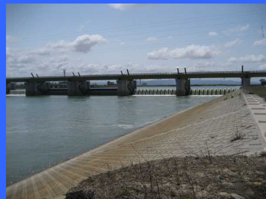
④ 左岸魚道下流より
