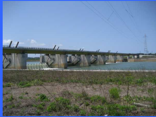
③ 右岸仮締切りより
