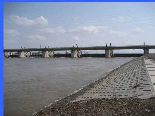
④ 左岸魚道下流より
