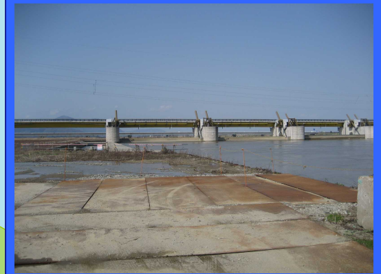
② 左岸魚道上流より
