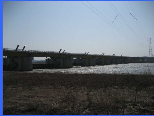
③ 右岸仮締切りより
