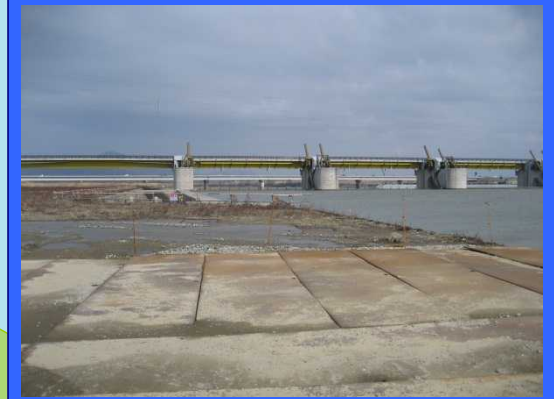
② 左岸魚道上流より
