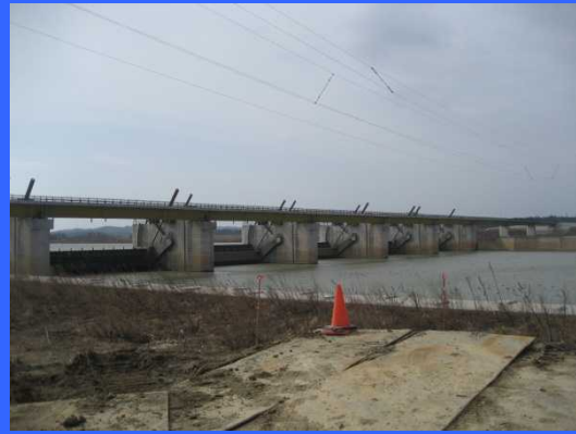
③ 右岸仮締切りより
