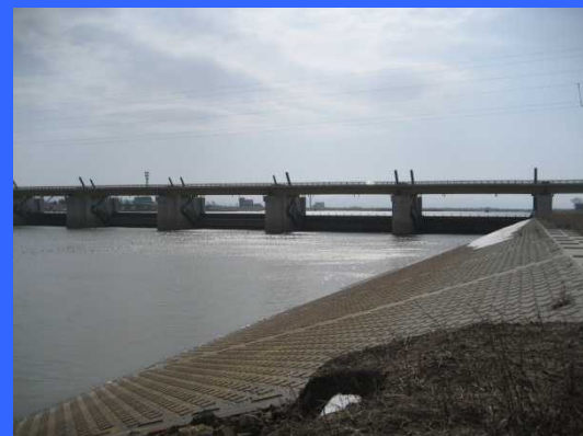
④ 左岸魚道下流より
