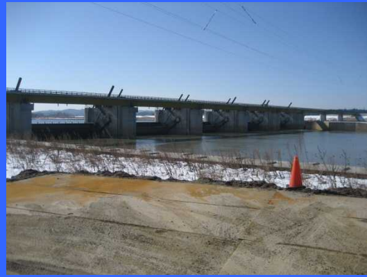
③ 右岸仮締切りより
