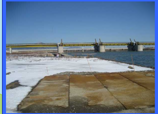
② 左岸魚道上流より
