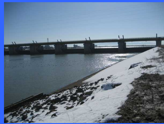
④ 左岸魚道下流より
