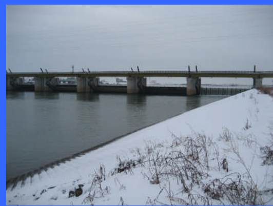
④ 左岸魚道下流より
