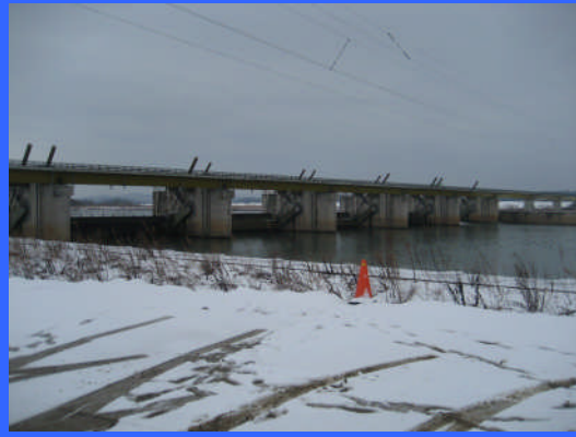
③ 右岸仮締切りより
