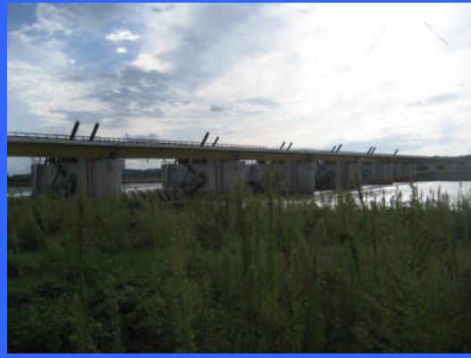
③ 右岸仮締切りより
