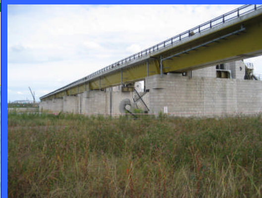
① 左岸仮締切りより
