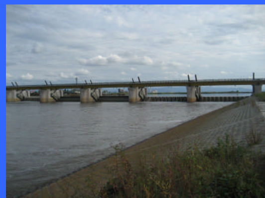
④ 左岸魚道下流より
