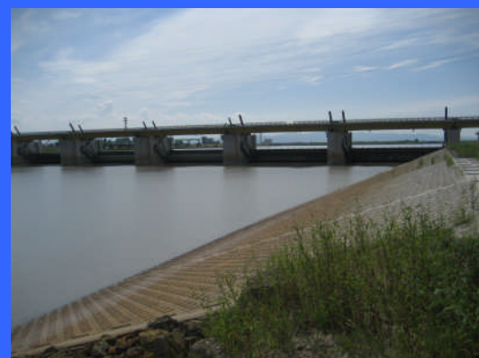
④ 左岸魚道下流より
