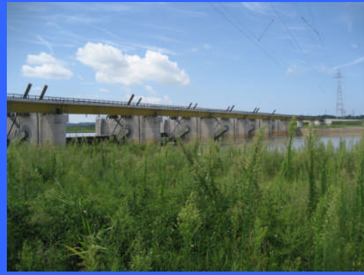
③ 右岸仮締切りより
