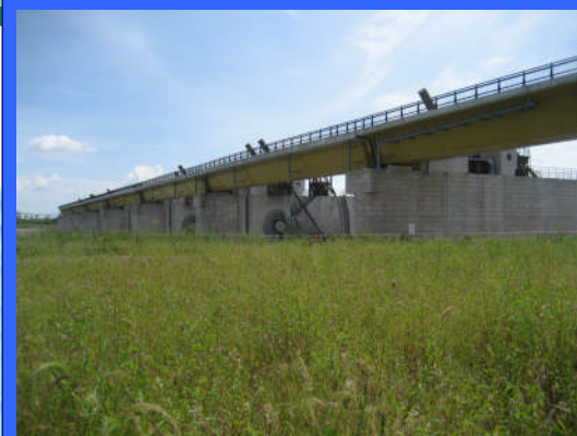
① 左岸仮締切りより
