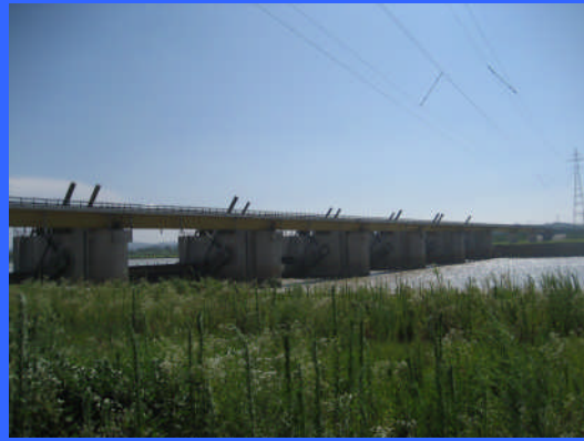
③ 右岸仮締切りより
