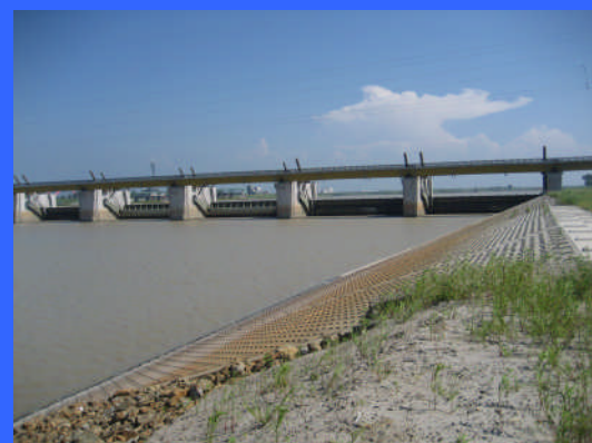
④ 左岸魚道下流より
