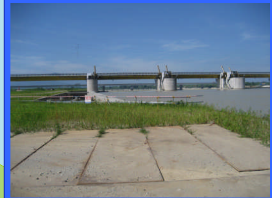
② 左岸魚道上流より
