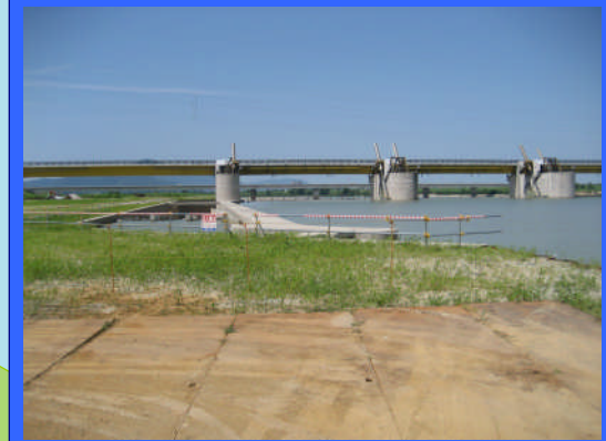
② 左岸魚道上流より
