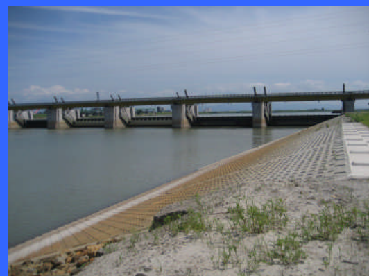
④ 左岸魚道下流より
