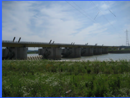
③ 右岸仮締切りより
