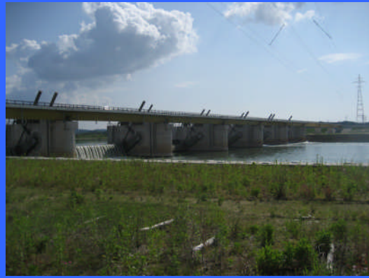
③ 右岸仮締切りより
