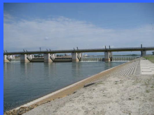
④ 左岸魚道下流より
