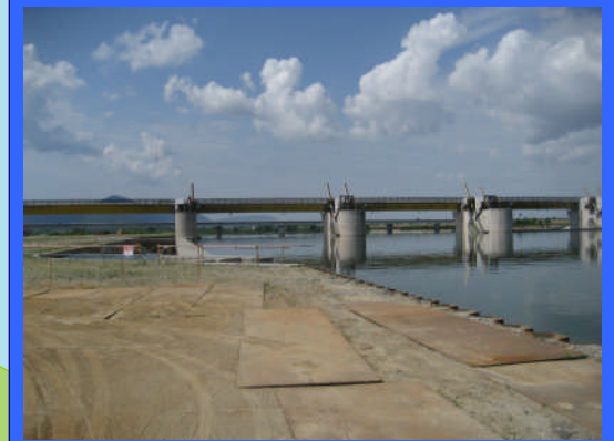
② 左岸魚道上流より
