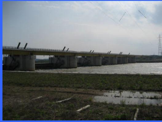
③ 右岸仮締切りより
