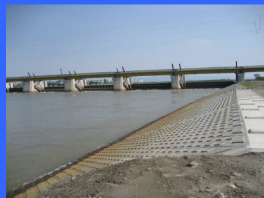
④ 左岸魚道下流より
