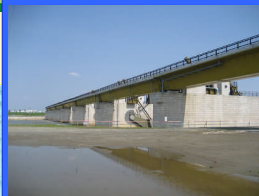
① 左岸仮締切りより
