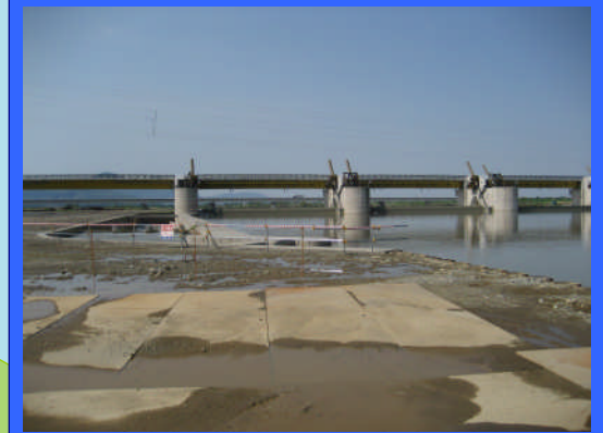
② 左岸魚道上流より
