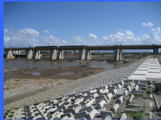
④ 左岸魚道下流より
