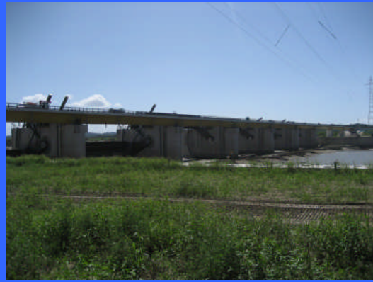
③ 右岸仮締切りより
