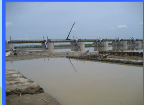
② 左岸魚道上流より
