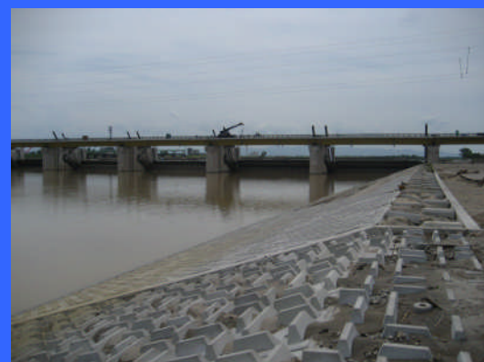
④ 左岸魚道下流より
