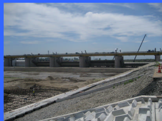
④ 左岸魚道下流より
