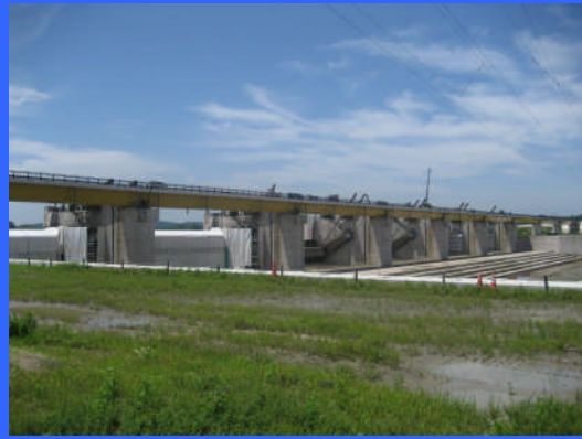
③ 右岸仮締切りより
