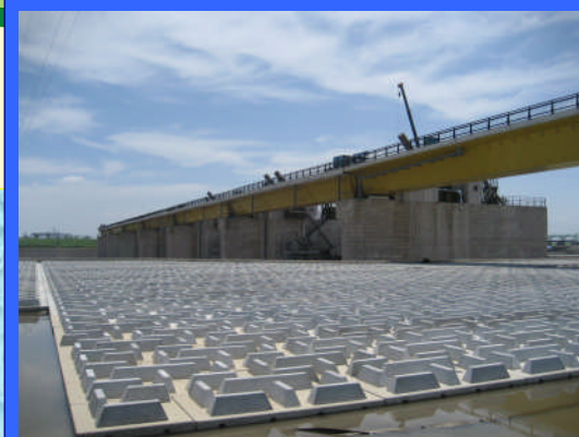
① 左岸仮締切りより
