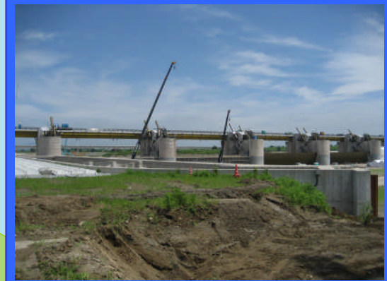
② 左岸魚道上流より
