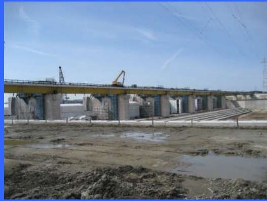
③ 右岸仮締切りより
