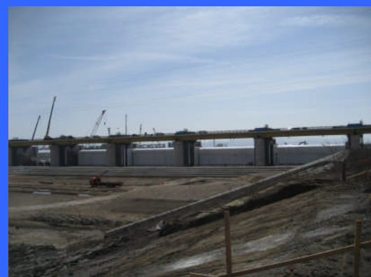
④ 左岸魚道下流より
