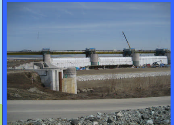
② 左岸魚道上流より
