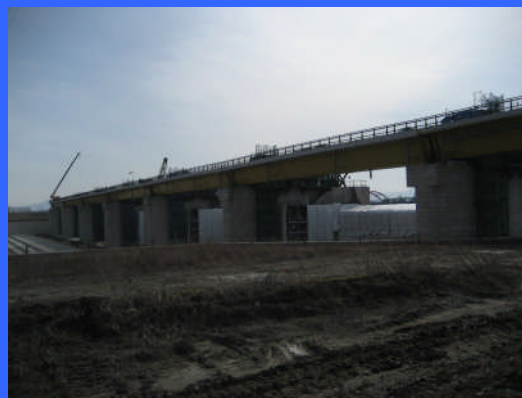
① 左岸仮締切りより
