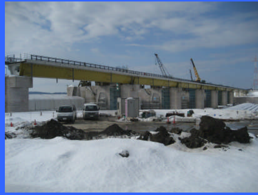
③ 右岸仮締切りより
