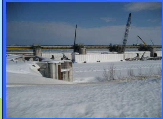
② 左岸魚道上流より
