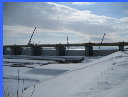
④ 左岸魚道下流より
