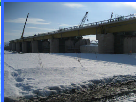
① 左岸仮締切りより
