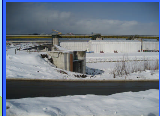
② 左岸魚道上流より
