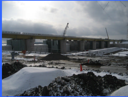
③ 右岸仮締切りより
