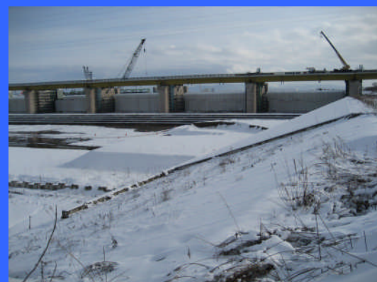
④ 左岸魚道下流より
