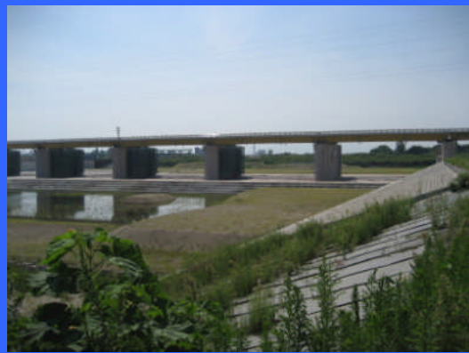
④ 左岸魚道下流より
