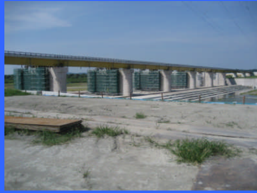
③ 右岸仮締切りより
