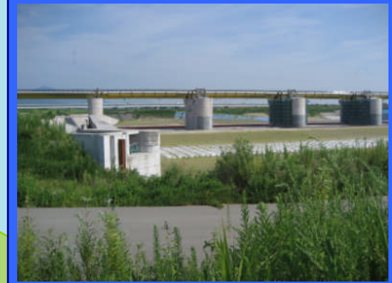
② 左岸魚道上流より
