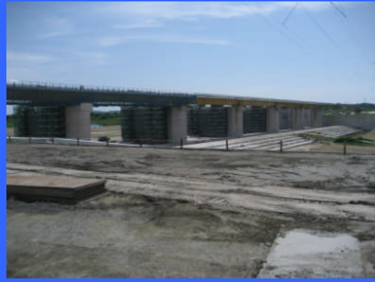
③ 右岸仮締切りより
