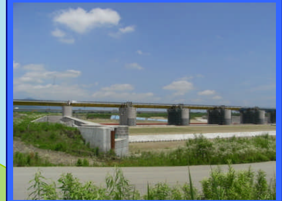
② 左岸魚道上流より
