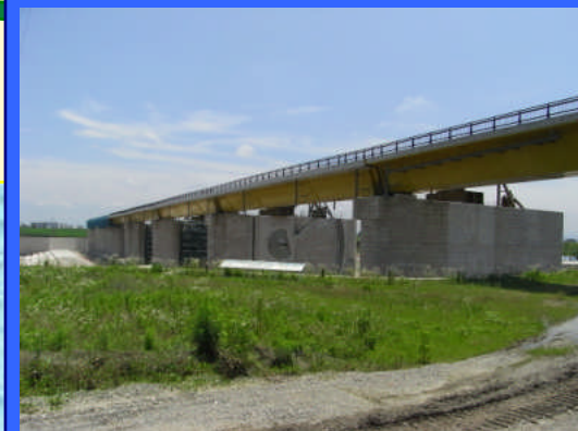
① 左岸仮締切りより
