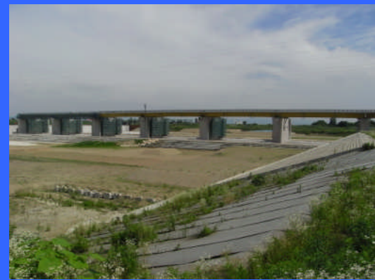
④ 左岸魚道下流より
