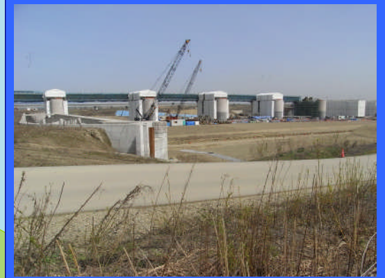
② 左岸魚道上流より
