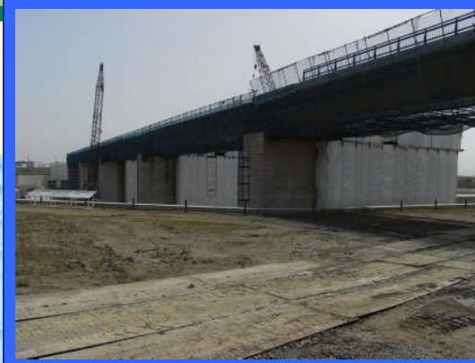
① 左岸仮締切りより
