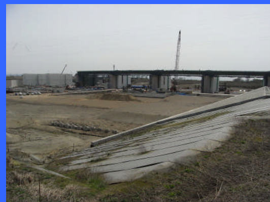
④ 左岸魚道下流より
