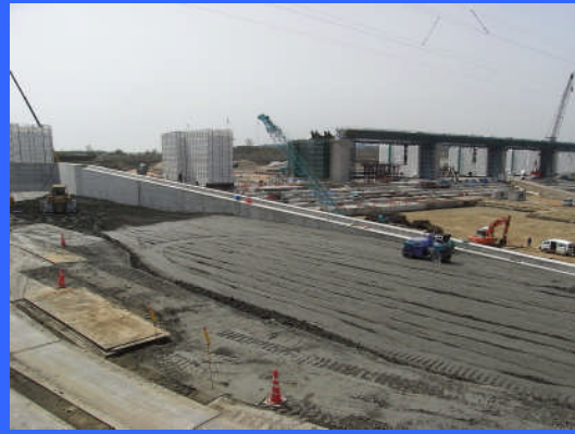
③ 右岸仮締切りより
