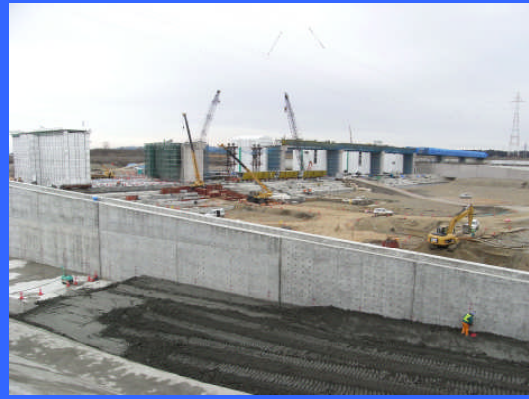
③ 右岸仮締切りより
