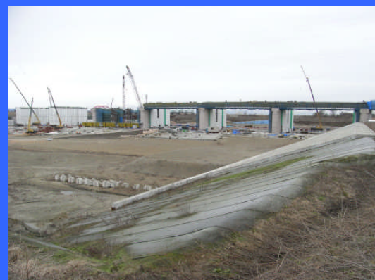
④ 左岸魚道下流より
