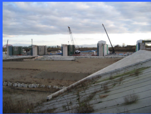
④ 左岸魚道下流より
