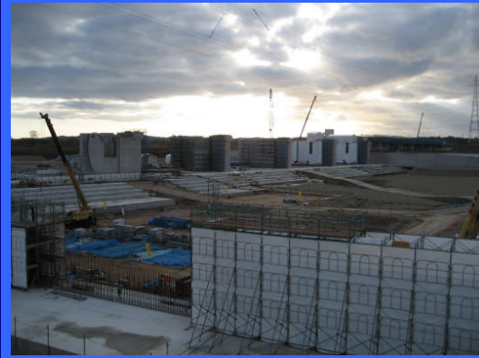
③ 右岸仮締切りより
