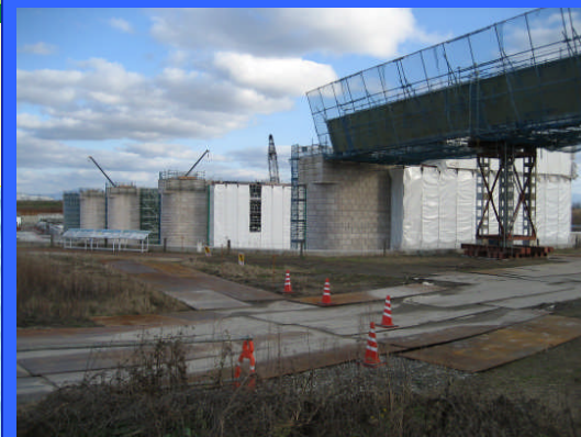
① 左岸仮締切りより
