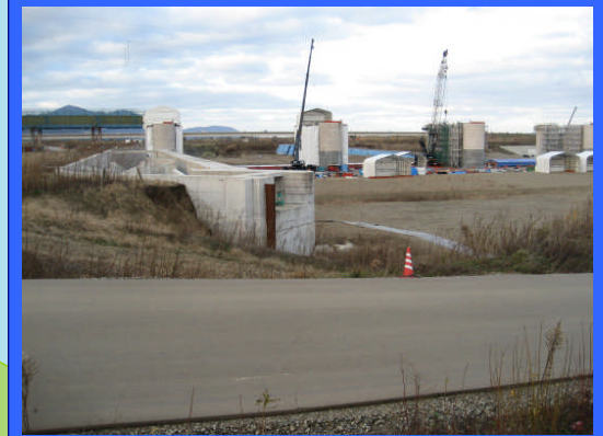
② 左岸魚道上流より
