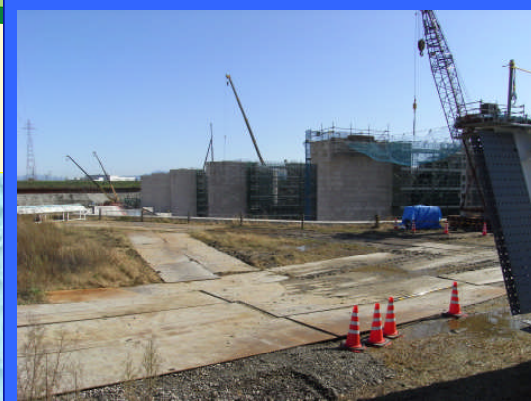
① 左岸仮締切りより
