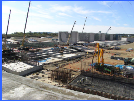
③ 右岸仮締切りより
