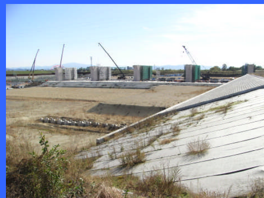
④ 左岸魚道下流より
