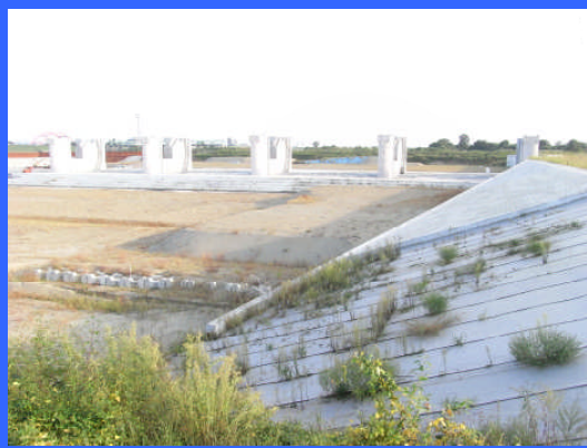
④ 左岸魚道下流より
