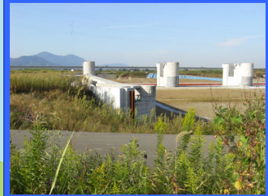
② 左岸魚道上流より
