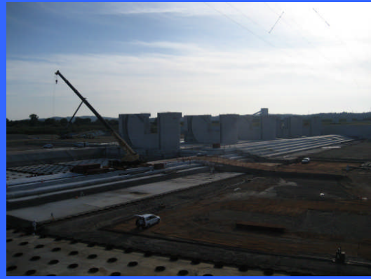
③ 右岸仮締切りより
