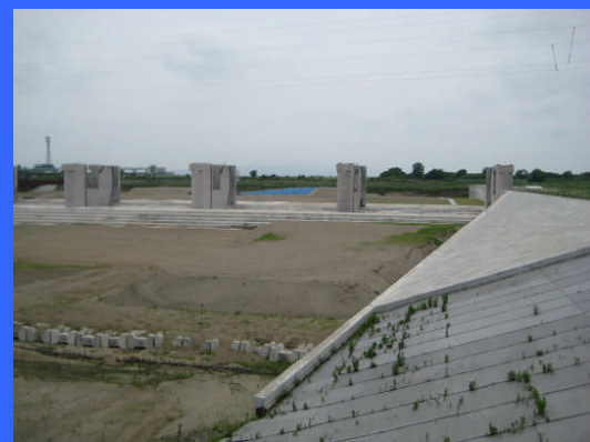
④ 左岸魚道下流より
