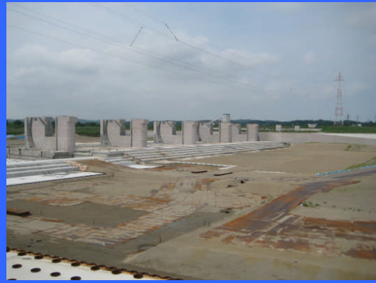
③ 右岸仮締切りより
