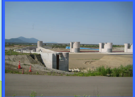
② 左岸魚道上流より
