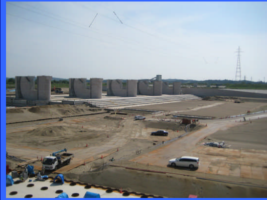
③ 右岸仮締切りより
