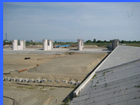
④ 左岸魚道下流より
