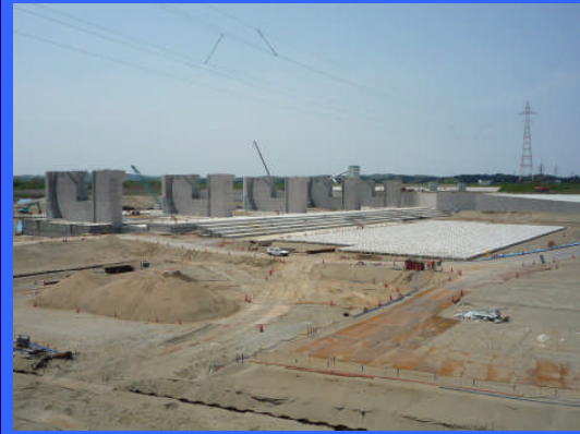
③ 右岸仮締切りより
