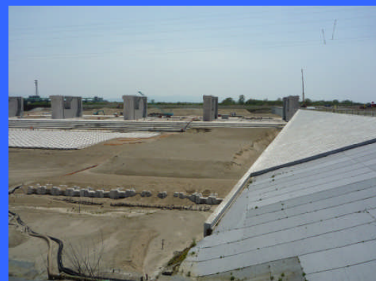
④ 左岸魚道下流より
