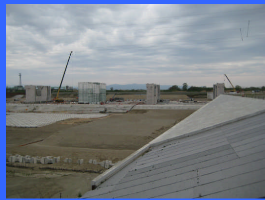
④ 左岸魚道下流より
