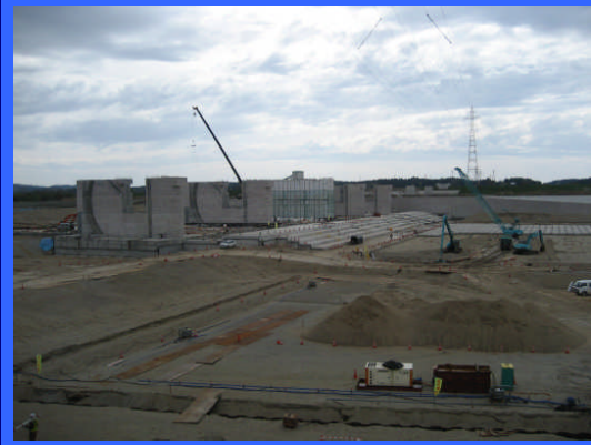
③ 右岸仮締切りより
