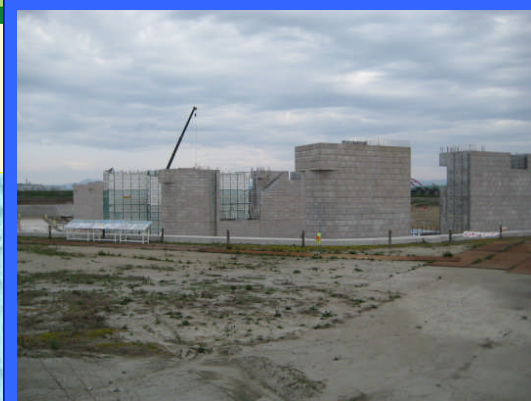
① 左岸仮締切りより
