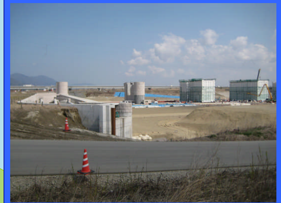
② 左岸魚道上流より
