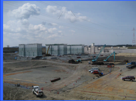
③ 右岸仮締切りより
