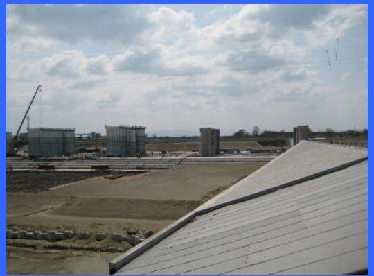
④ 左岸魚道下流より
