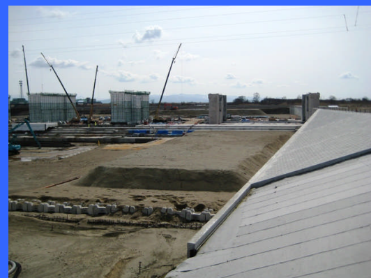
④ 左岸魚道下流より
