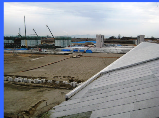
④ 左岸魚道下流より
