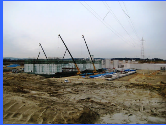
③ 右岸仮締切りより
