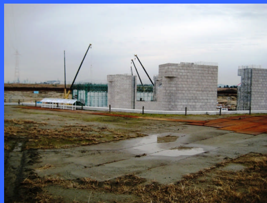
① 左岸仮締切りより
