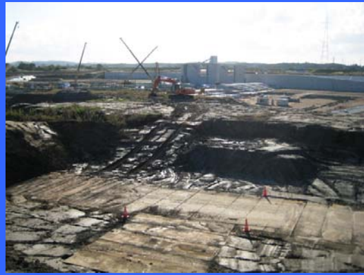
③ 右岸仮締切りより
