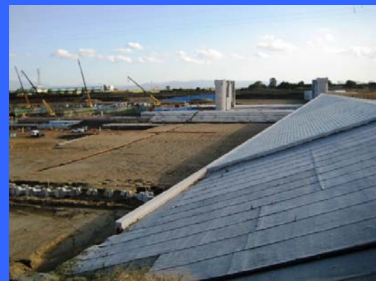
④ 左岸魚道下流より
