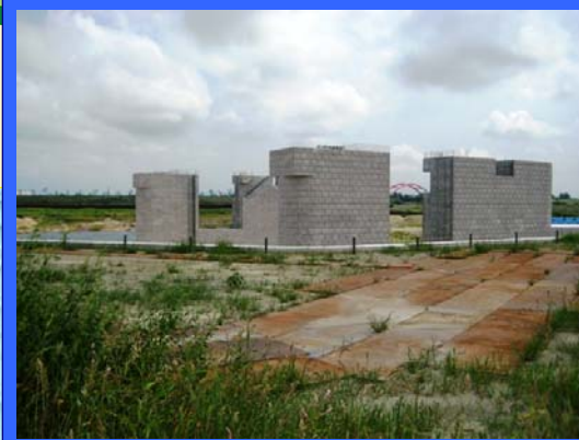
① 左岸仮締切りより
