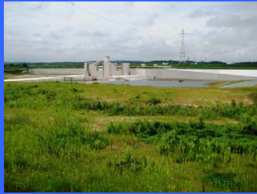
③ 右岸仮締切りより
