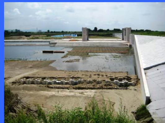
④ 左岸魚道下流より
