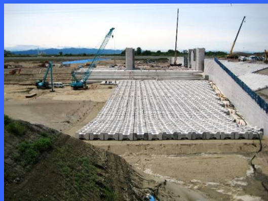
④ 左岸魚道下流より
