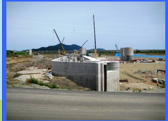
② 左岸魚道上流より
