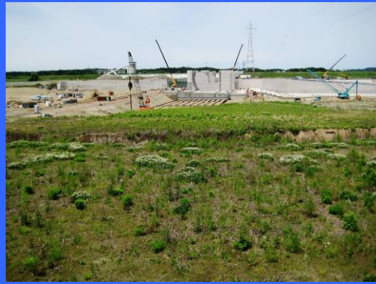
③ 右岸仮締切りより
