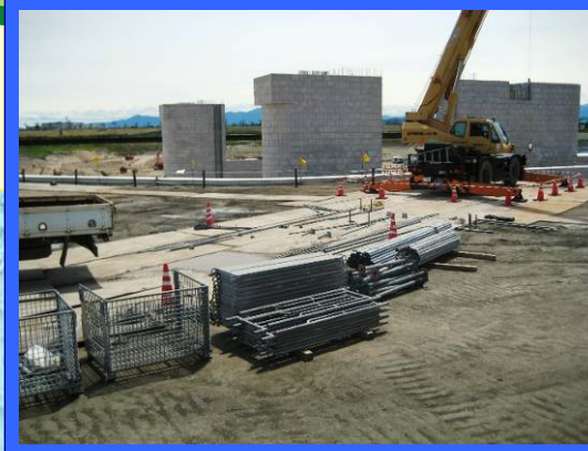
① 左岸仮締切りより
