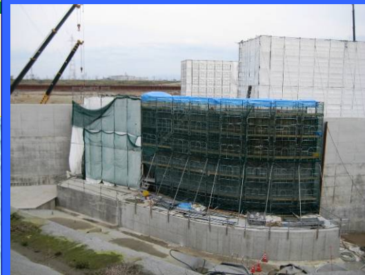
① 左岸仮締切りより
