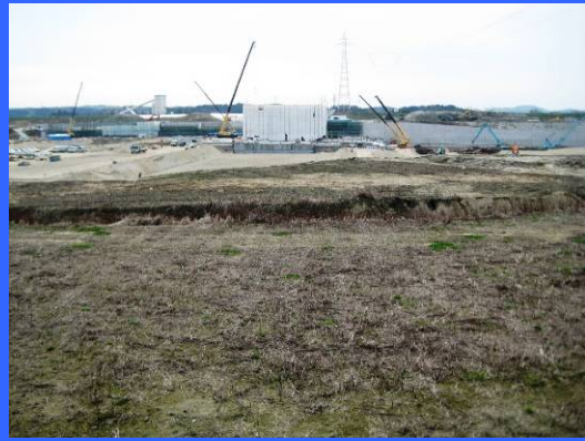
③ 右岸仮締切りより
