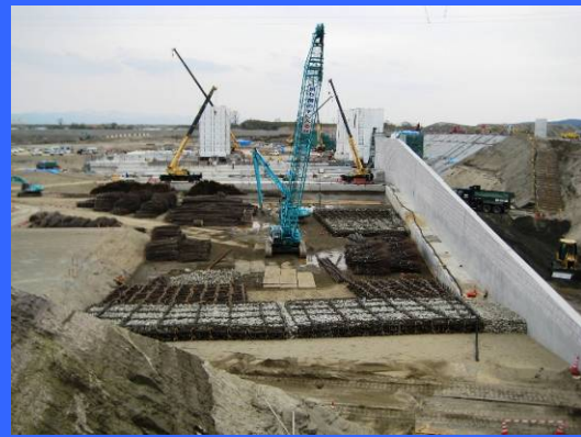
④ 左岸魚道下流より
