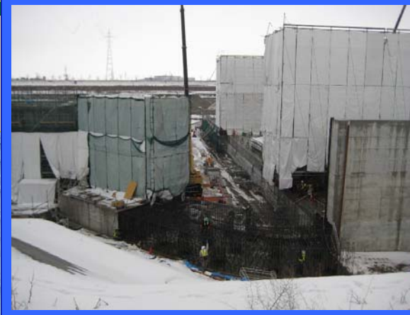
① 左岸仮締切りより
