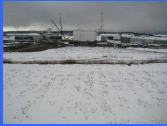
③ 右岸仮締切りより
