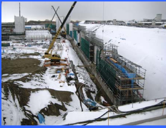
④ 左岸魚道下流より
