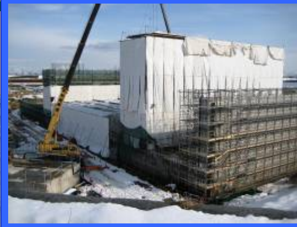
① 左岸仮締切りより
