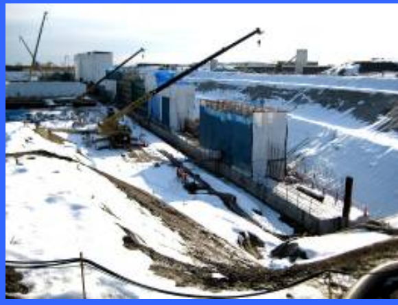
④ 左岸魚道下流より
