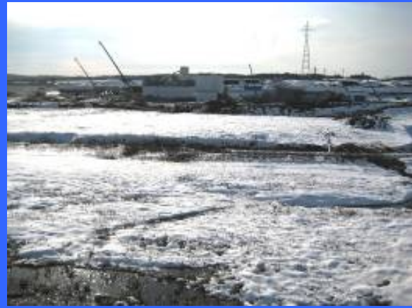
③ 右岸仮締切りより
