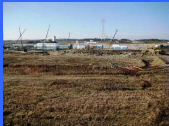
③ 右岸仮締切りより
