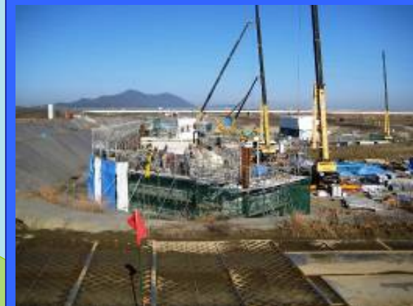
② 左岸魚道上流より
