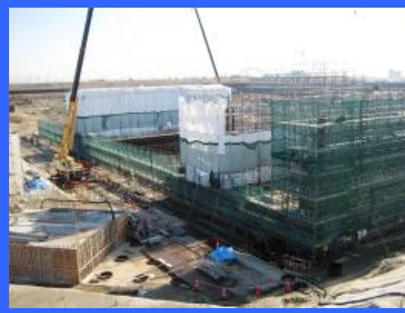
① 左岸仮締切りより
