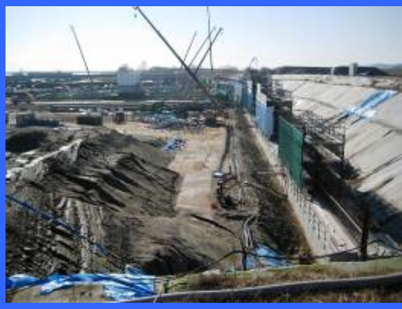
④ 左岸魚道下流より
