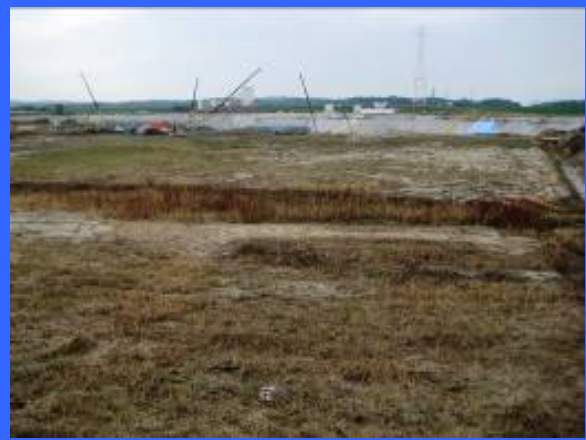
③ 右岸仮締切りより
