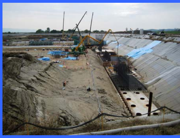
④ 左岸魚道下流より
