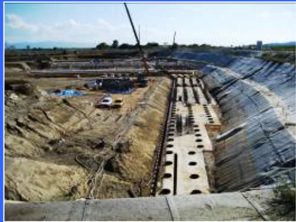
④ 左岸魚道下流より
