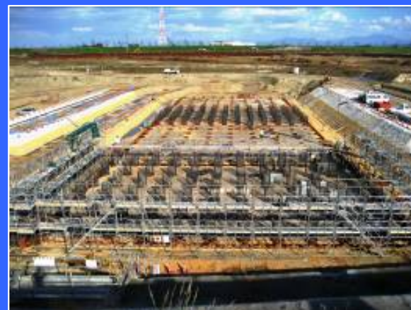
① 左岸仮締切りより
