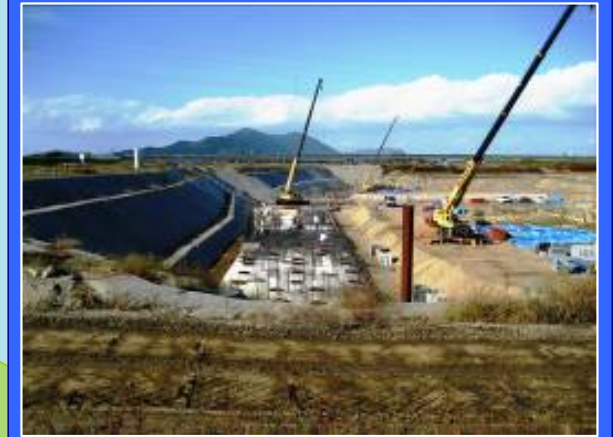
② 左岸魚道上流より
