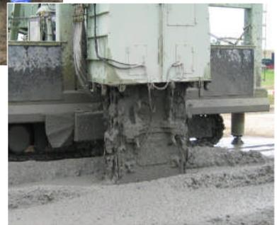
↑ 現地の土砂とベントナイト及びセメントをかき混ぜてコンクリートの壁を土中に約30mの深さで作ります。
