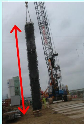
↑ 現地の土砂とベントナイト及びセメントをかき混ぜてコンクリートの壁を土中に約30mの深さでつくります。
