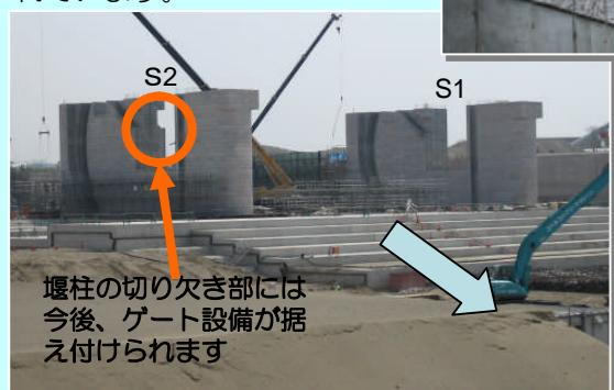
完成した堰柱2基（S1,S2堰柱）
