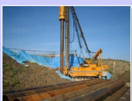
基礎杭(鋼管杭)施工
