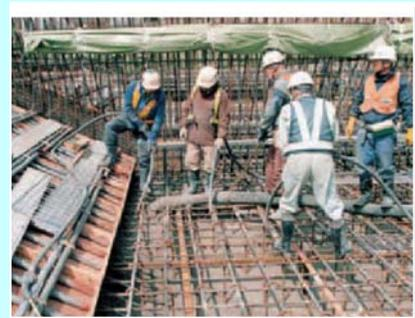
バイブレータによる締固め
