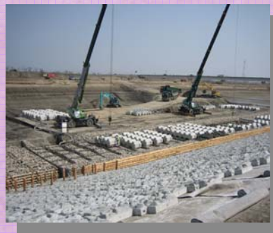
根固（異形）ブロック据付
