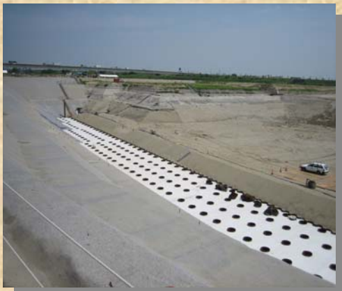
取付擁壁基礎杭施工状況
