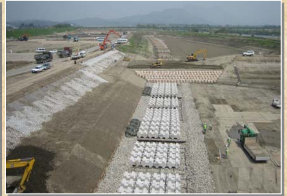
低水護岸完成
