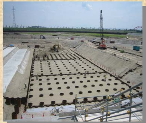
堰本体基礎杭施工状況
