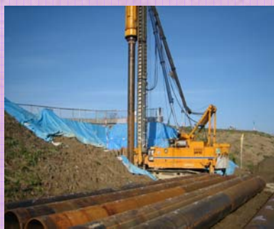
基礎杭（鋼管杭）施工
