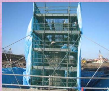
躯体施工状況
