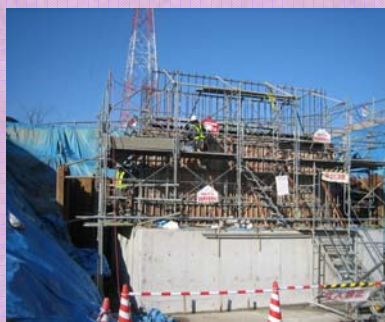
躯体施工状況
