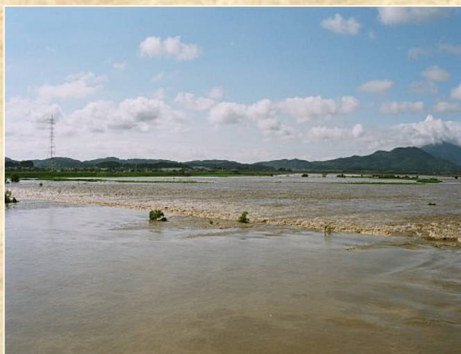
H18.7.19(2006)撮影 (洪水時の状況)
