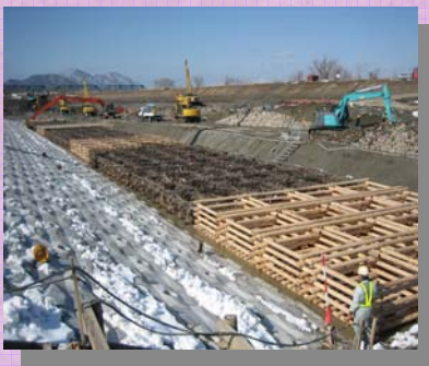
粗朶沈床・木工沈床組立
