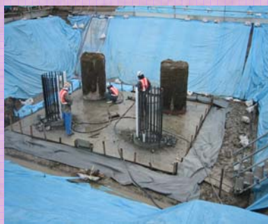
基礎杭（場所打杭）施工
