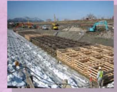
粗朶沈床・木工沈床組立
