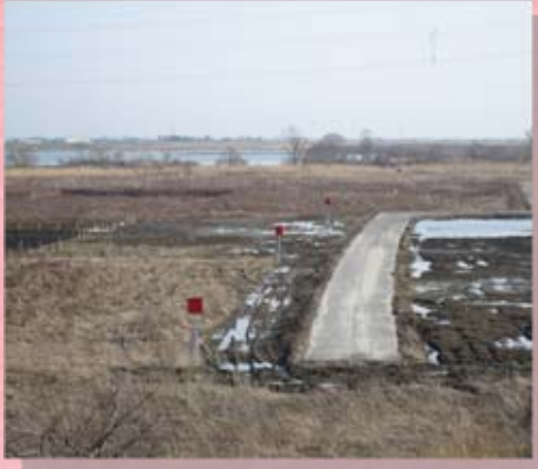
工事前の様子
