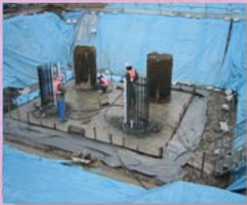
基礎杭（場所打杭）施工
