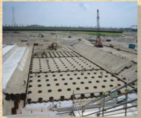
堰本體基礎杭施工状況
