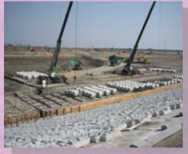
根固(異形)ブロック据付
