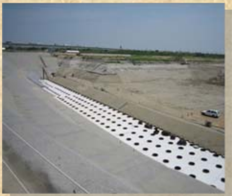
取付擁壁基礎杭施工状況
