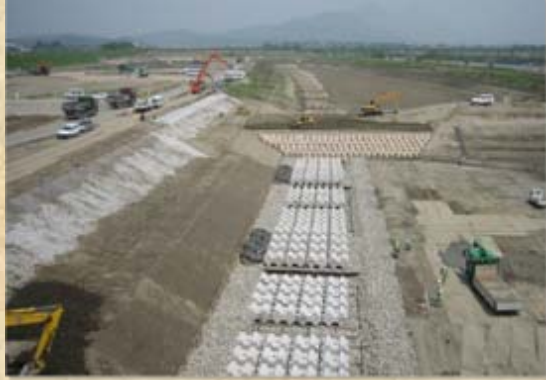
低水護岸完成
