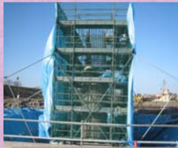
躯体施工状況
