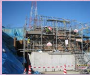
躯体施工状況
