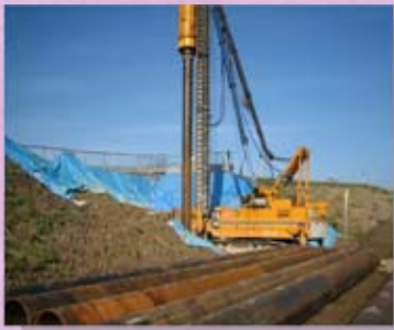
基礎杭（鋼管杭）施工
