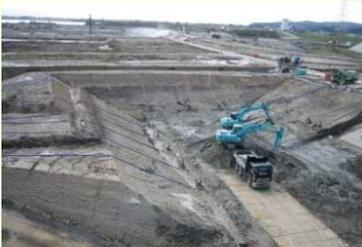
掘削した土砂は右岸の高水敷造成の他、信濃川下流の築堤工事や分水さくら公園の盛土工事及び近隣の圃場整備工事などに利用されました。
