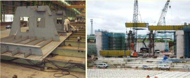
堰を管理するために必要な「管理橋」は、工場で小割りにつくられた鋼製の桁を陸路で現場へ運搬し、現場内で一部を組み立てた後に、200tの大型トラッククレーンで架設を行いました。
