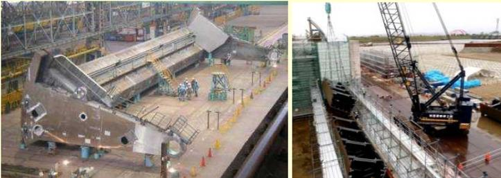
可動堰で採用されているラジアルゲートは長さ40m、幅12mもあり、国内最大規模です。一門を8分割にし、工場から運搬、現地にて組み立てました。
