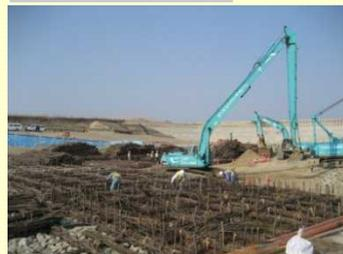
洗掘防止の目的で河川構造物の上下流に設ける施設で、河川伝統工法の粗朶沈床を採用しています。
