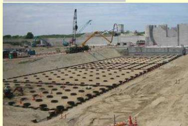
本体をささえる基礎には、約1500本の鋼管杭(径800mm~1100mm)を打込みました。
