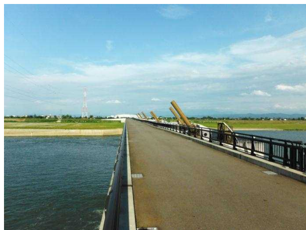
可動堰管理橋
