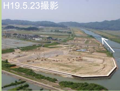
遮水工(地中連続壁工)
