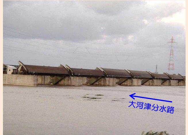
ゲートを全開にして洪水対応中の可動堰
